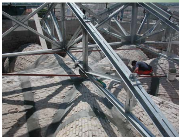
Applicazioni rinforzi volte in fibra di carbonio e copertura in acciaio
