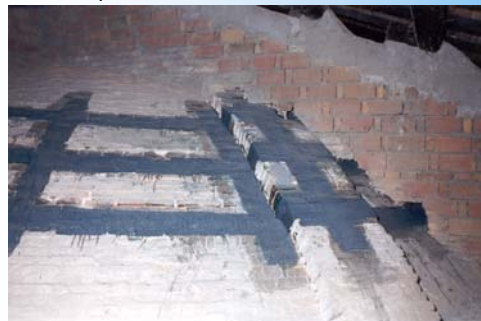
Applicazione fibra di carbonio
