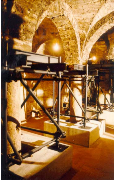
Vista Opere provvisionali cripta
