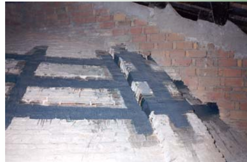
Applicazione fibra di carbonio
