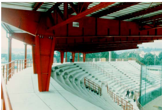
Tribuna e copertura
