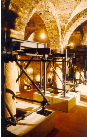
Vista Opere provvisionali cripta
