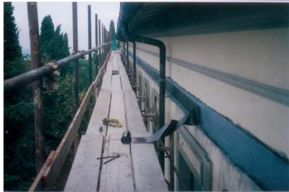
Applicazione rinforzi in fibra di carbonio
