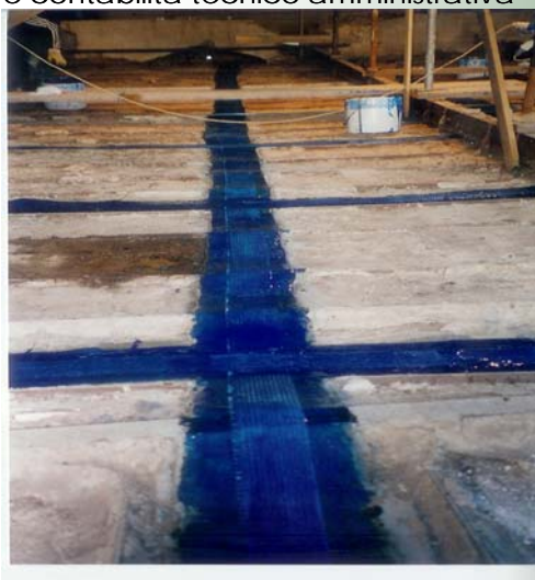
Applicazioni rinforzi volte in fibra di carbonio
