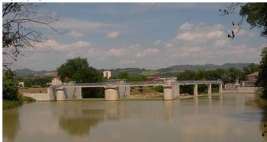
Vista d'insieme diga
