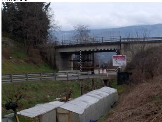
Vista d'insieme Ponte
