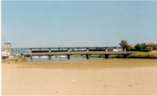
Visione della parte di ponte a 5 luci
