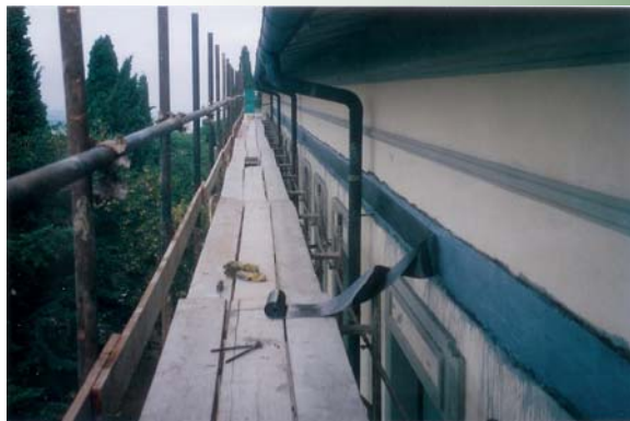
Applicazione rinforzi in fibra di carbonio
