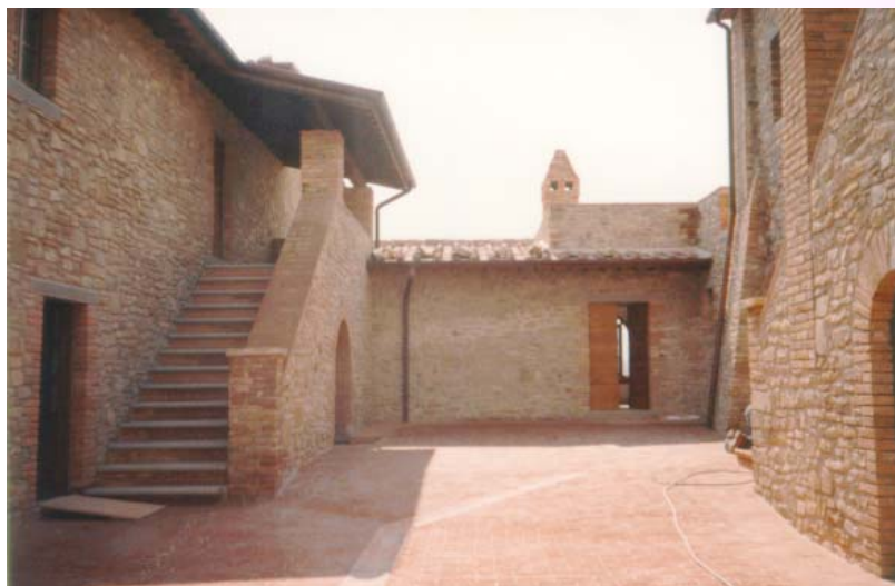
Vista della piazza interna
