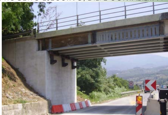
Vista dei rinforzi sul ponte
