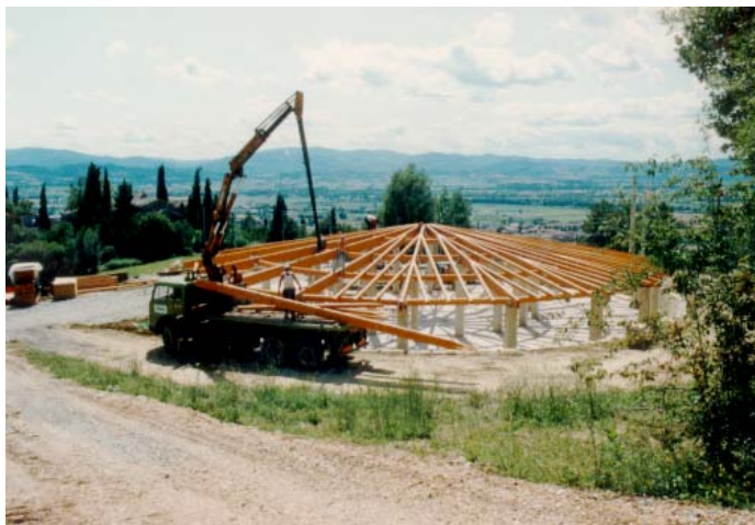
Montaggio struttura in legno lamellare
